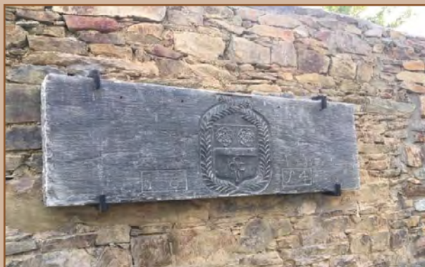
Pose de la PIERRE D'ARDOISE de la cheminée du PRESBYTERE ! A gauche de la médiathèque ! N'hésitez pas à passer !
