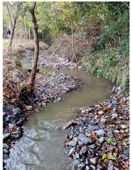
Après travaux sur le ruisseau de Méguinel à Sion les Mines
