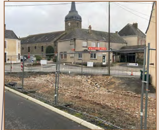
Démolition des deux maisons Rue Joseph Lardeux et sécurisation du lieux en prévision de l'aménagement du carrefour.
