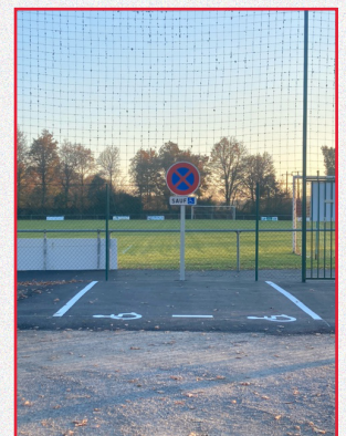
Création d'un stationnement accès PMR
