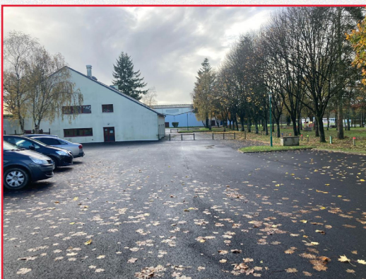
Mise en enrobé du parking de la cantine
